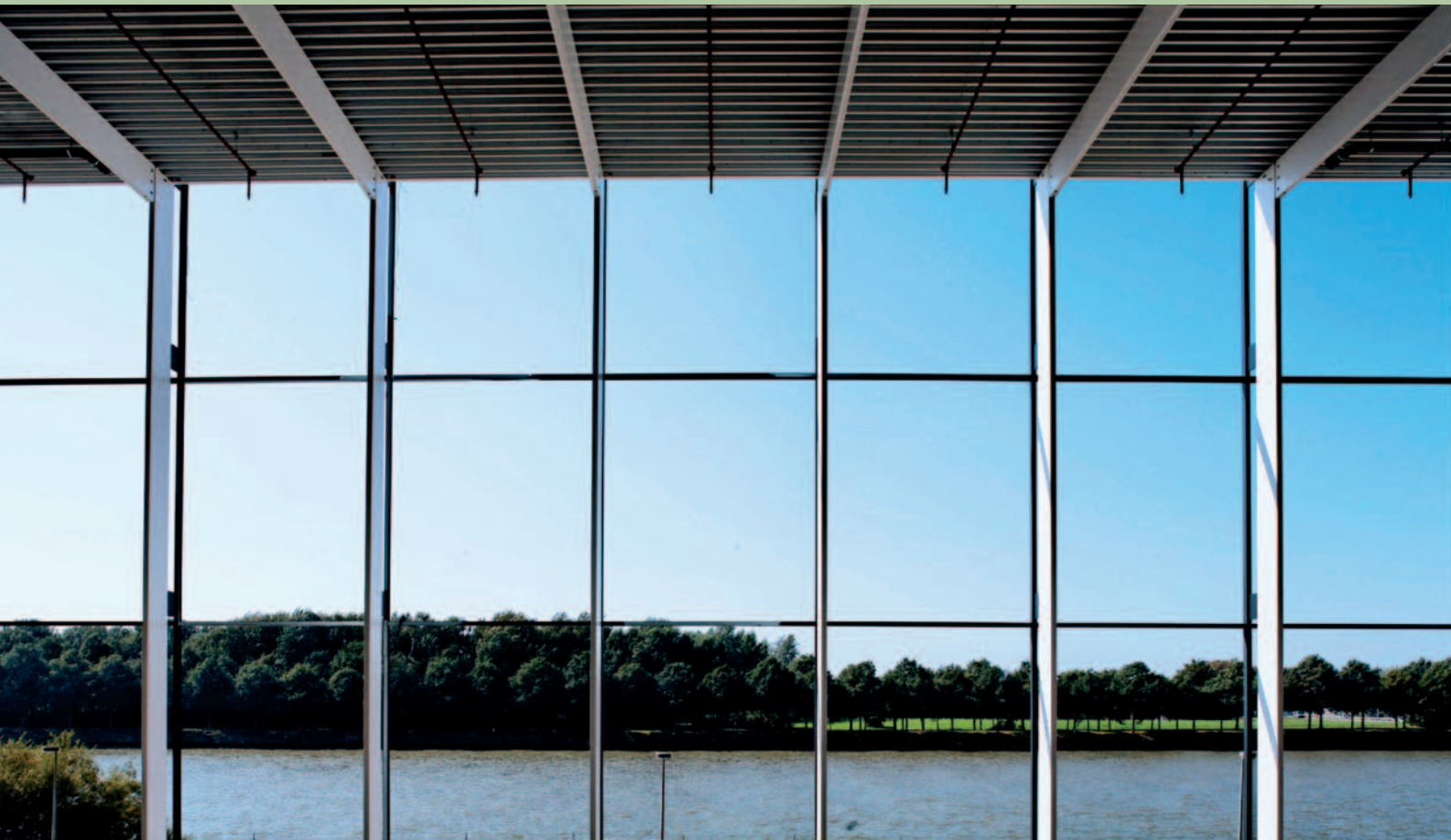
Afb. 10. Staalconstructie gebouw West-Raven in Utrecht.
