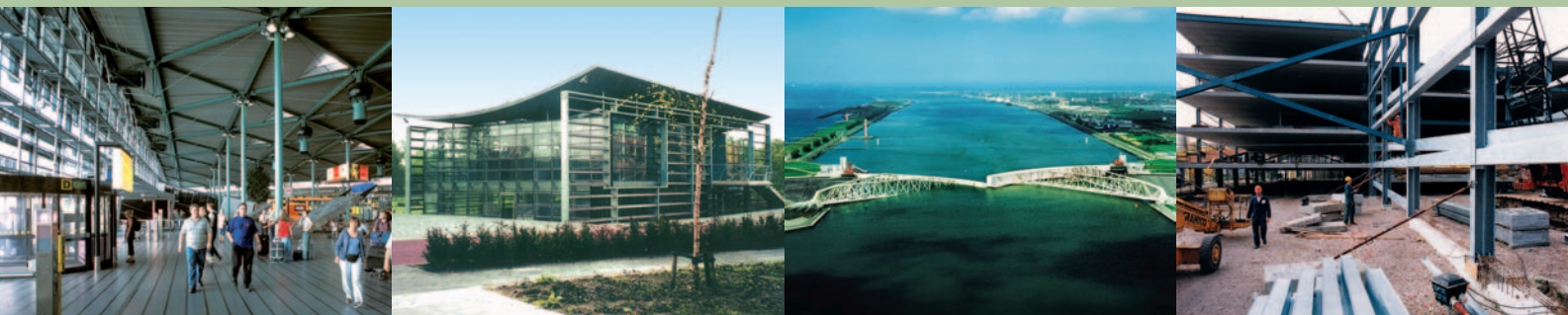
Voorbeelden van staalconstructies in verschillende klimaatklassen: de vertrekhal van Schiphol (binnenklimaat, klimaatklasse C2), kantoorgebouw Toon van Aken (klimaatklasse C3), Maeslantkering (klimaatklasse C4), Parkeergarage Tivoli (klimaatklasse C3).
