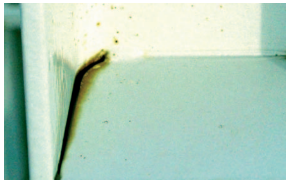
Afb. 13b. Horizontale verstijvingsschotten in (bijvoorbeeld) kolommen vermijden.
