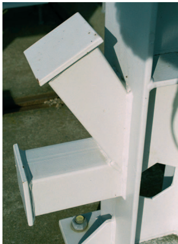
Afb. 9. Ontmoetingen van kokerprofielen in een verticaal vlak moeten vermeden worden.
