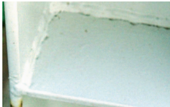
Afb. 13a. Rondom aflassen vermijdt corrosie.
