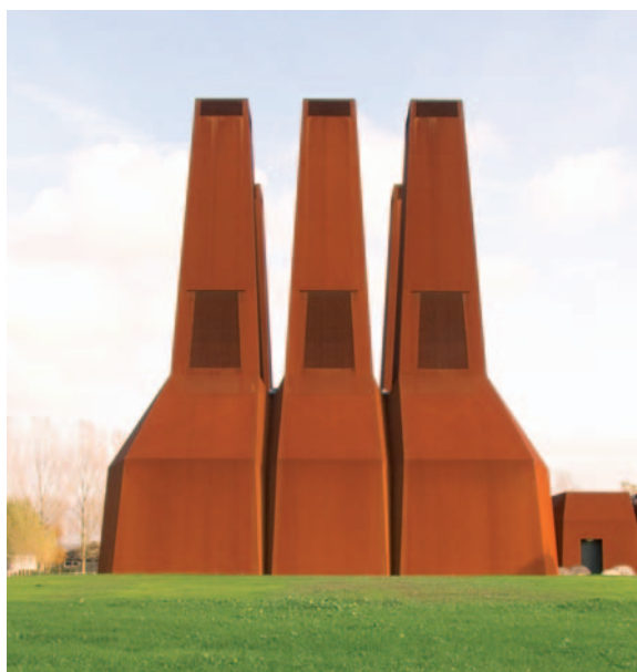
Afb. 17a. Onderhoudsvrije' Omkasting warmtekrachtmachines op de Uithof te Utrecht uitgevoerd in weervast staal.
