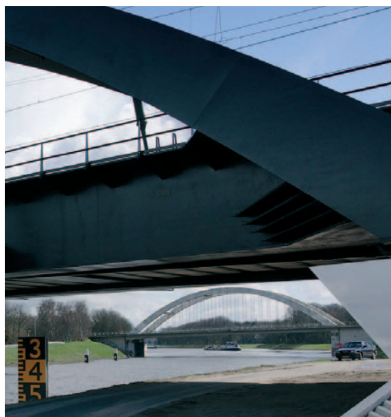
Afb. 17b. Detail van de spoorbrug over het Twentekanaal. Constructie is gealuminiseerd.
