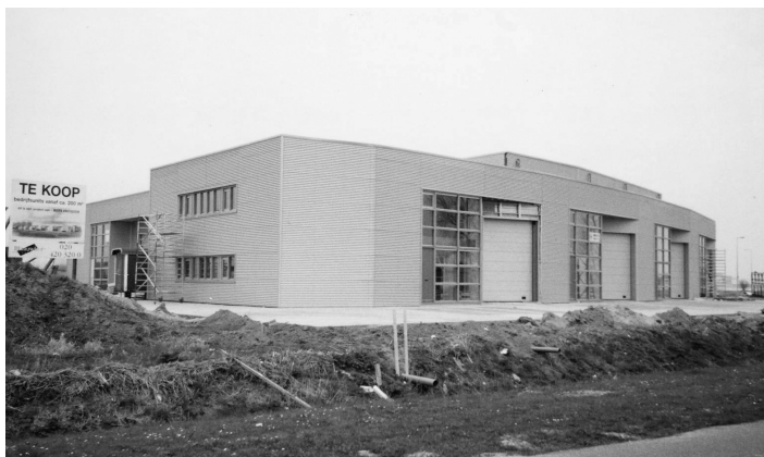
Distributiehhal in staalbouw (Foto's: Bouwen met Staal)
