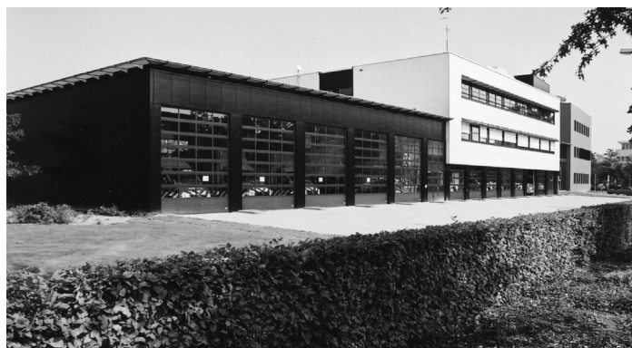
Brandweergarage in staalbouw
