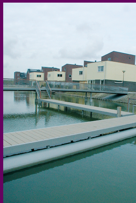
Overzichtsfoto van de avontuurlijke brug.
