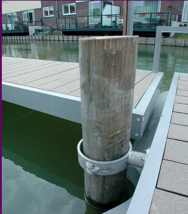
Roestvaststalen beugels kunnen scharnieren als het slot geopend is.
