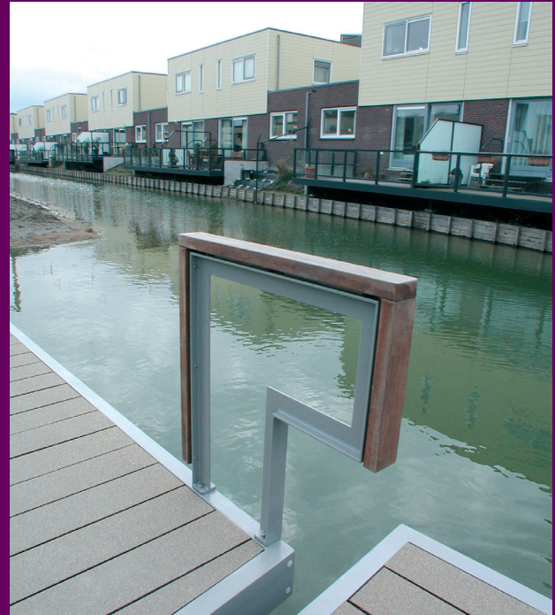
Een hekwerk helpt de bezoeker als het drijvende gedeelte bij een lage waterstand laag ligt.
